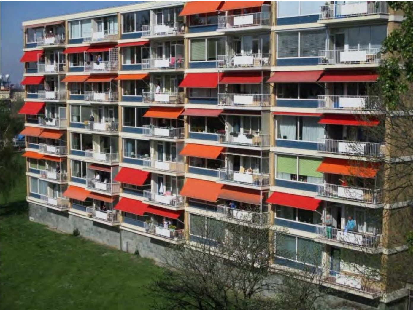
De 'gele' flats op de Havendijk/Maasboulevard kennen blokverwarming: foto Mari Dingenouts
